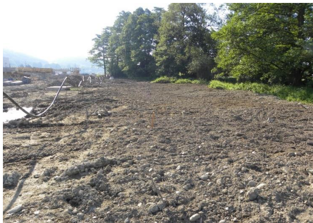
Obr 1 Príprava plochy pred obnovou Fig 1 Site preparation before restoration
